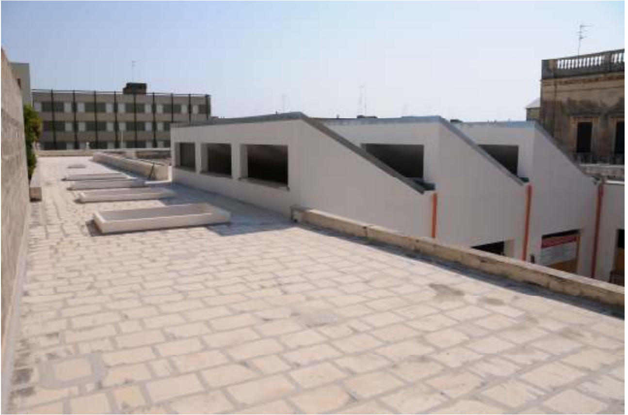
Vista delle coperture
