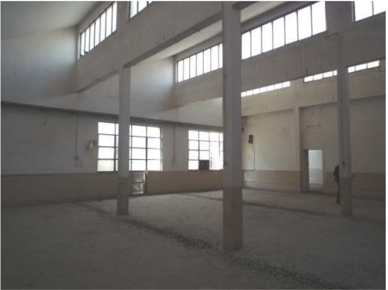
Vano 3 – prima dei lavori; tipologia di infissi da riproporre
