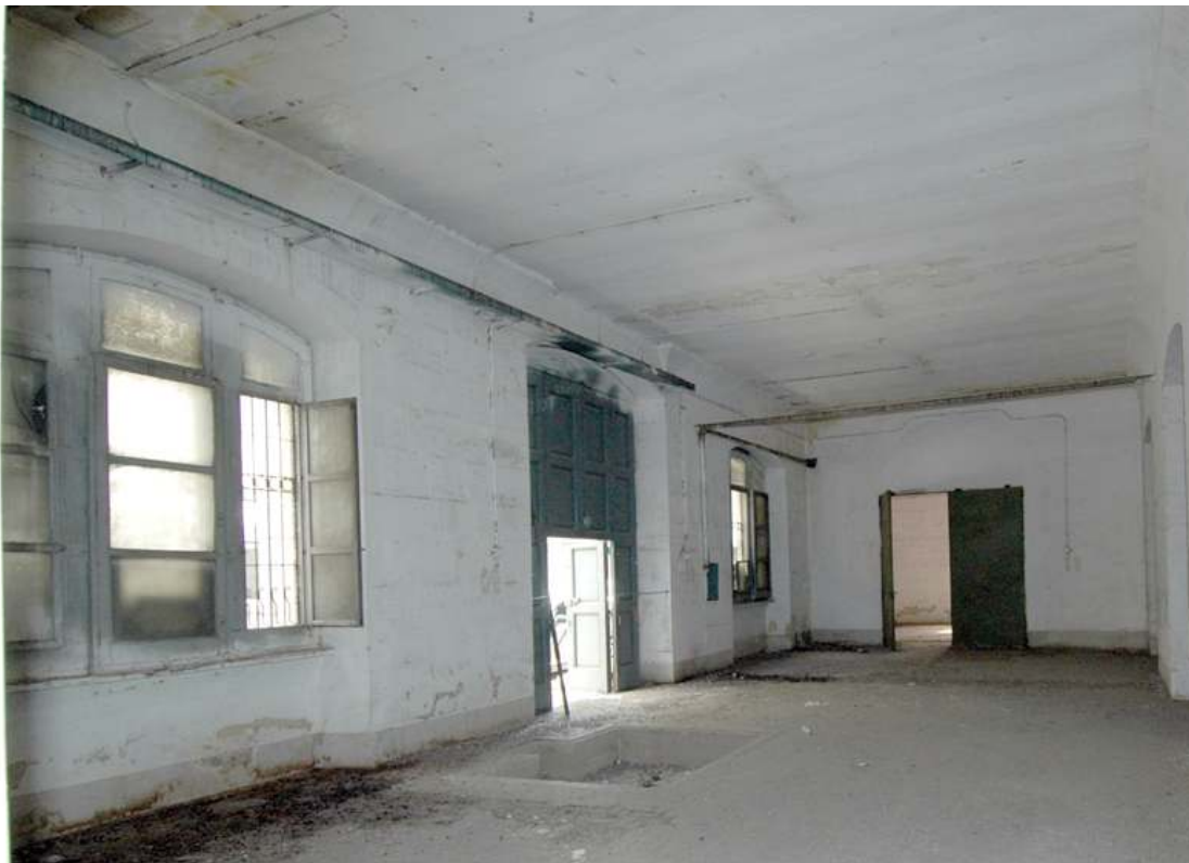
Vano 8 – prima dei lavori; tipologia di infissi da riproporre
